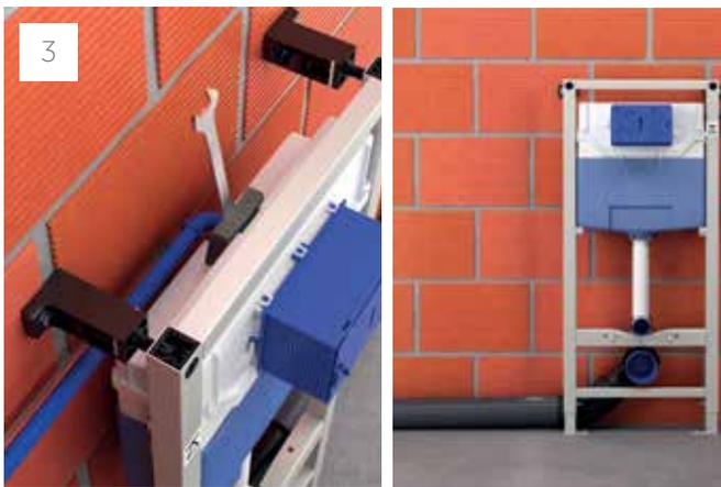
3 Installer les pipes d'alimentation et d'évacuation au bâti support et raccorder les kits de protection sur les manchettes et les tiges filetées.
