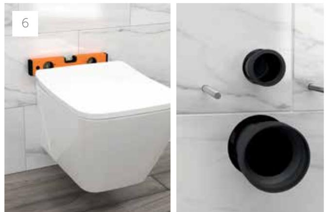
6 Installer la cuvette sur les tiges filetées du bâti support et s'assurer, à l'aide d'un niveau, de la planéité de la cuvette.
