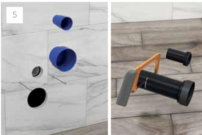
5 Déposer les kits de protection et couper les pipes d'alimentation et d'évacuation en prenant en compte les dimensions de la cuvette et la profondeur de l'habillage du bâti support.
